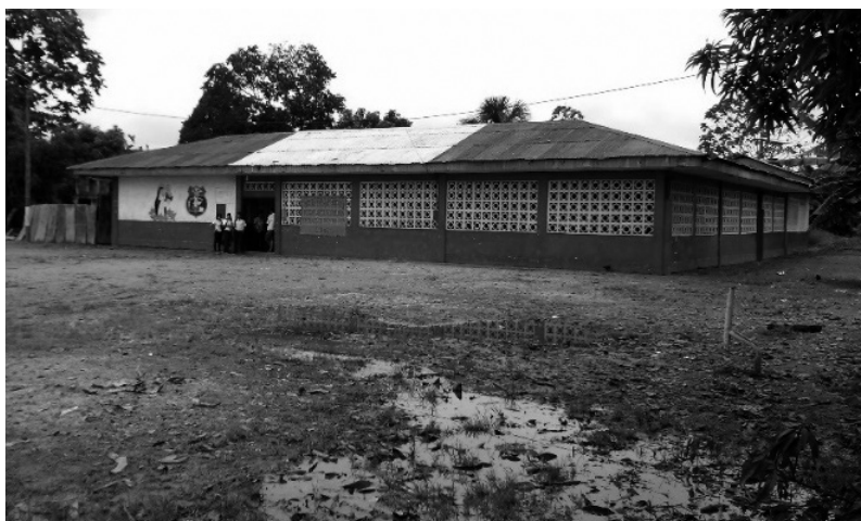
Figura 4 – Escola Municipal no Distrito de Santa Rosa - Peru
